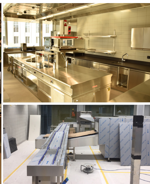
Direktionsküche / Abwäscherei im Bau
