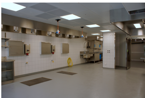
Mieterausbau Flughafen Zürich AG
