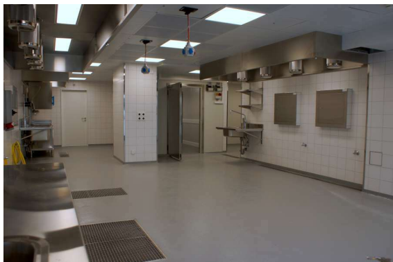
Mieterausbau Flughafen Zürich AG
