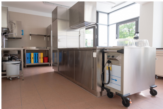
Abwäscherei - Mittelblock Rückseite
