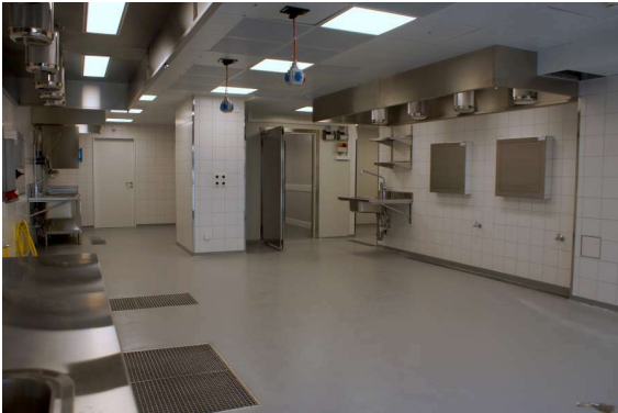
Mieterausbau Flughafen Zürich AG
