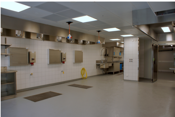
Mieterausbau Flughafen Zürich AG
